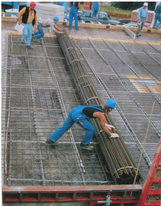
Figur 2 Exempel på rationellt armeringsnät som enkelt rullas ut och kan skräddarsys på fabrik [4].
